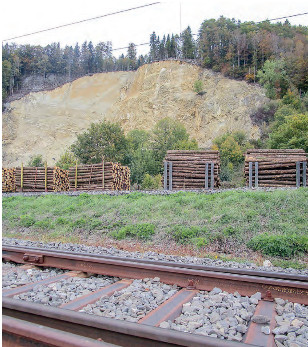
In Col-des-Roches hat die Bahn mit Holz und Tunnelausbruchmaterial genug zu transportieren.
